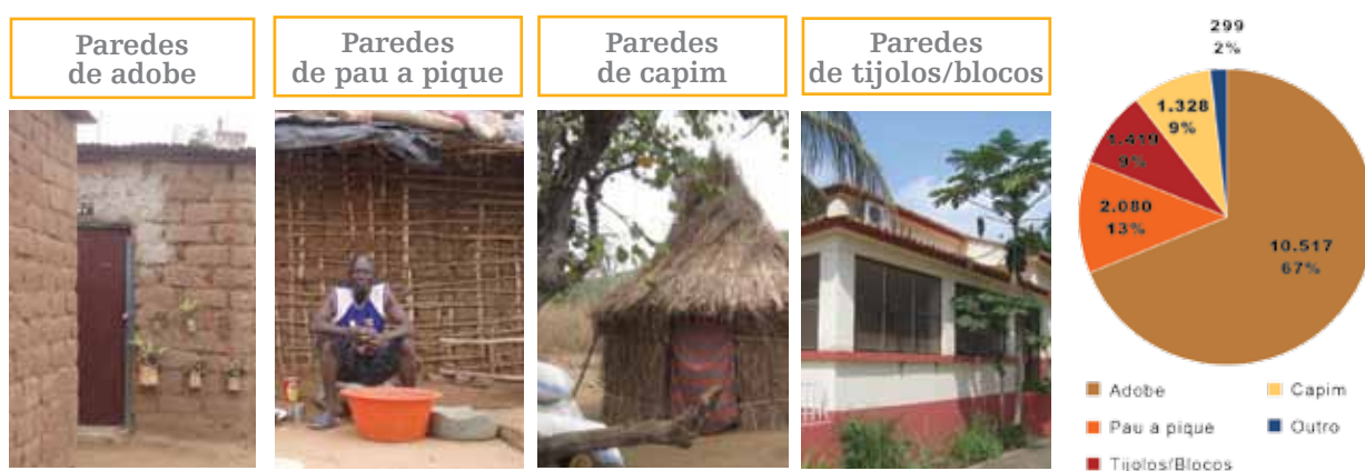
Figura 9 - Material usado nas paredes na área de estudo.
